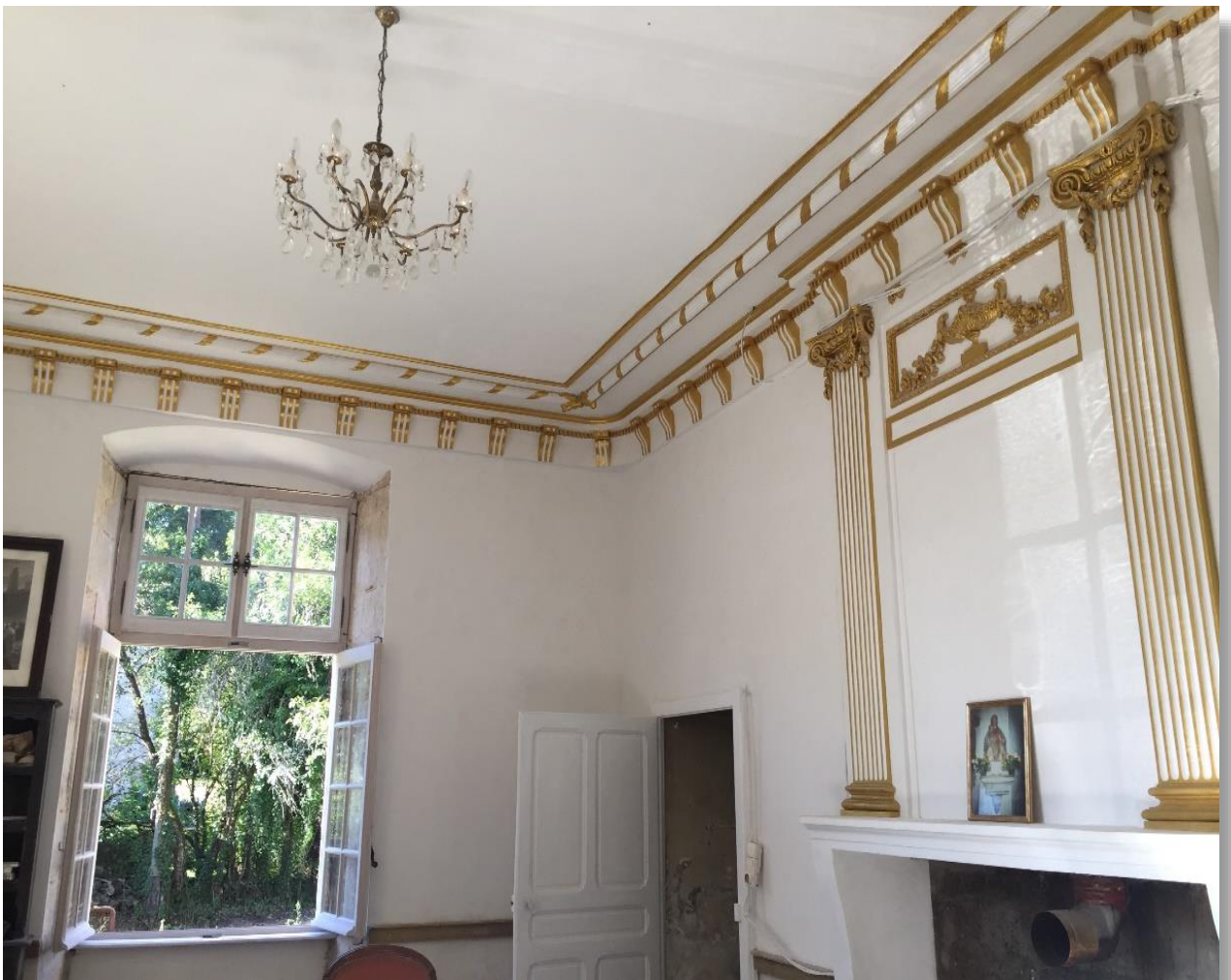
Fenêtre refaite et stucs rénovés de la pièce du palais abbatial à l'abbaye de Cherville
