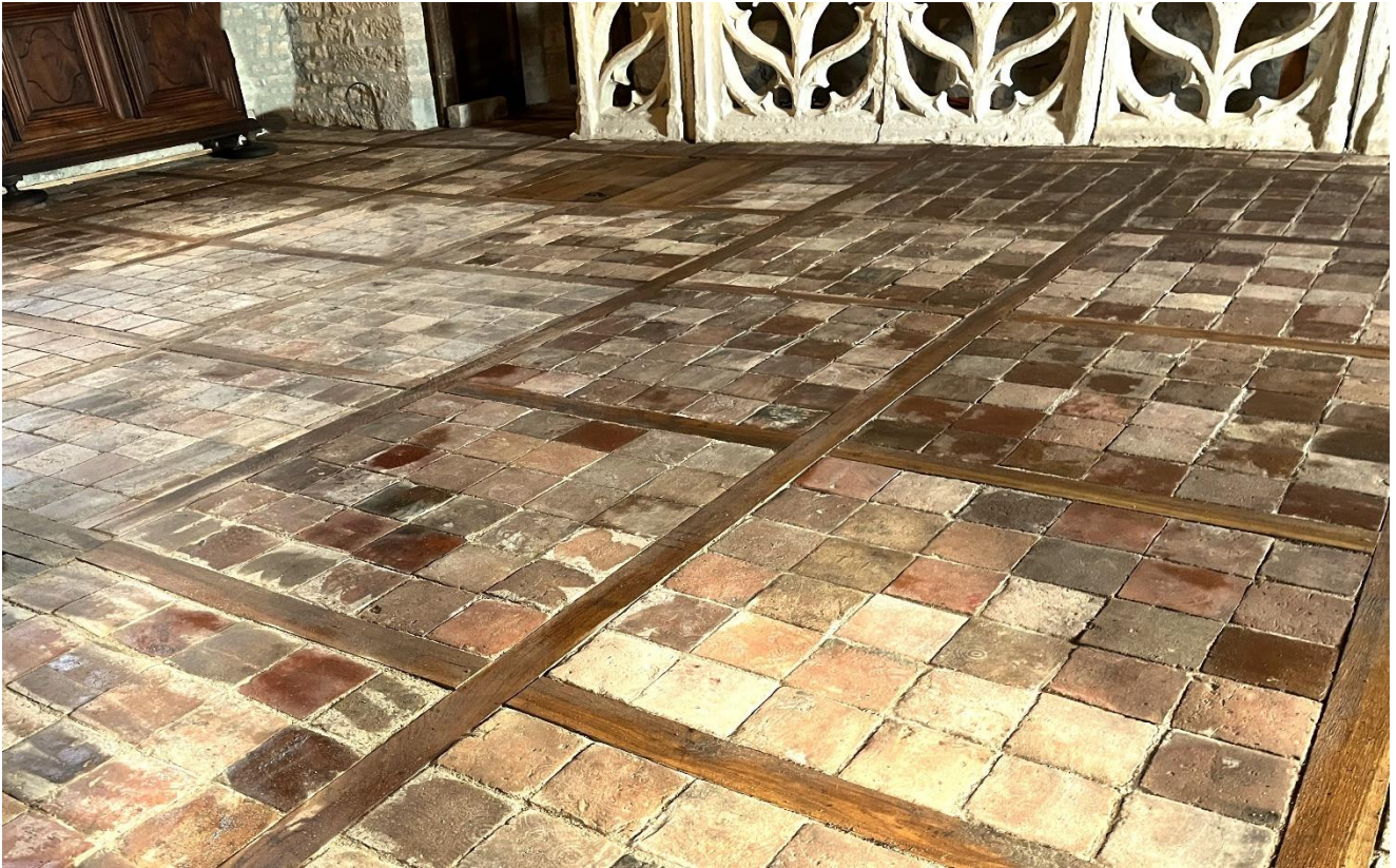
Sol réalisé en 2023 au 2 ème étage
