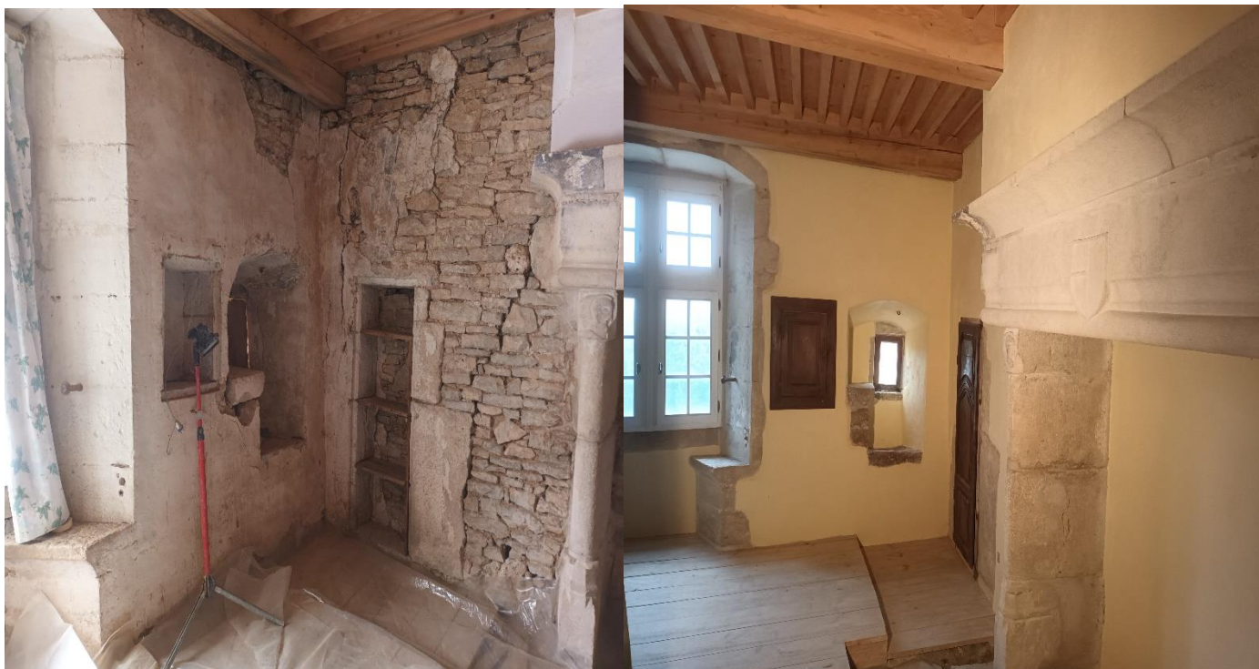
La chambre avant et après restauration par l'entreprise Pierre Vallondesancey
